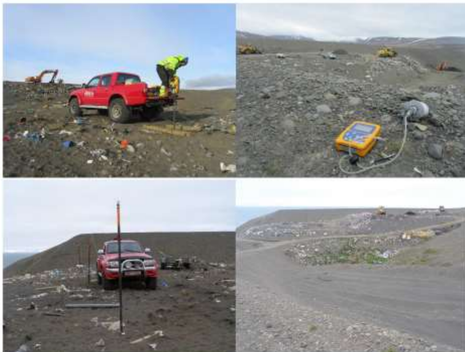
Mynd 2: Niðurstetning gasmæliróra og gasmælingar á Stekkjarvík.
