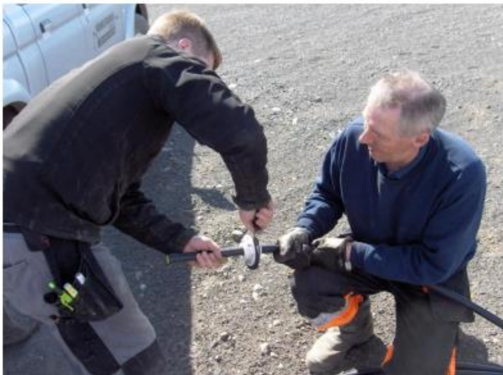
Frágangur á loku 25 mm PE mælirörs
